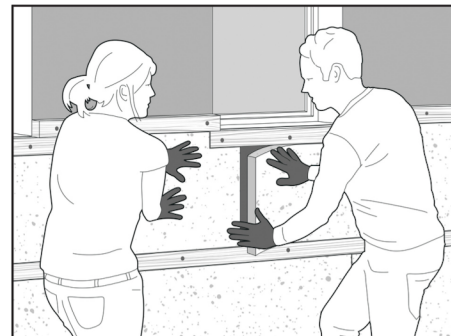
Установите утеплитель в шахматном порядке на одном уровне с горизонтальными брусками.
